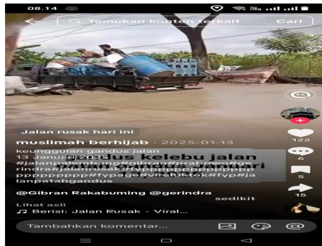
Gambar 2. Gambar kondisi jalan Kecamatan Gandus
