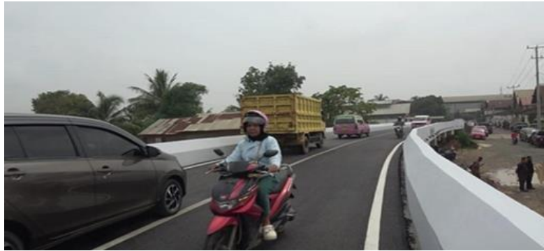
Gambar 1. Gambar Jalan Layang Kecamatan Gandus
